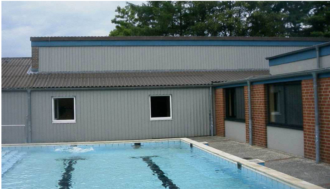
Foto Schwimmbadhof Bauabschnitt II
