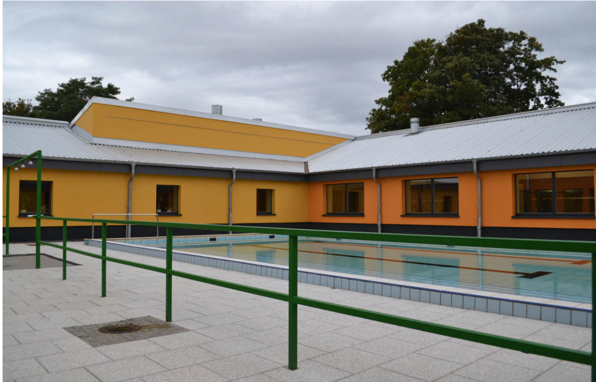
Foto Schwimmbadhof Bauabschnitt II
