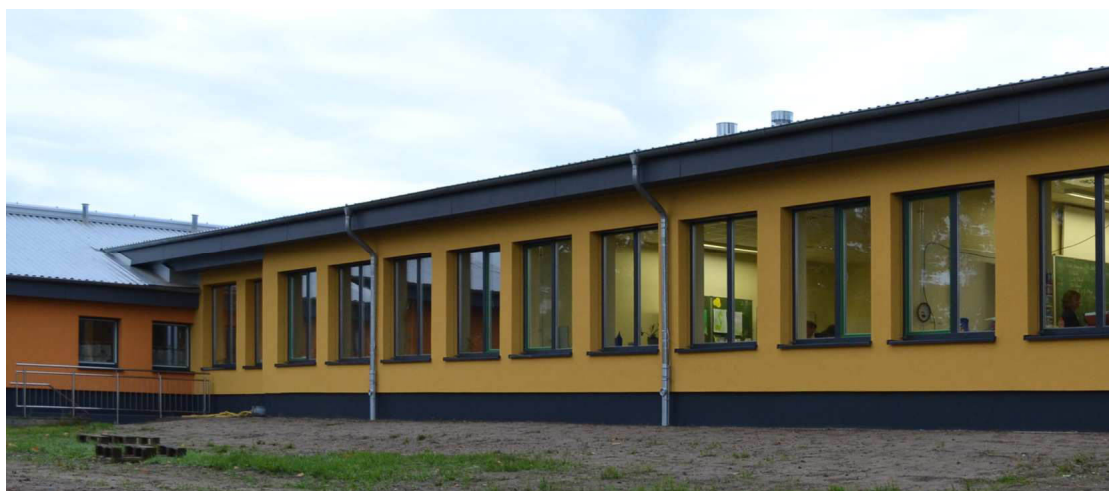
Foto Klassentrakt Bauabschnitt I
