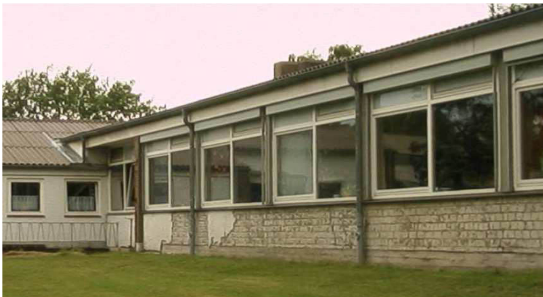
Foto Klassentrakt Bauabschnitt I
